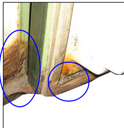
Gambar 7.2 Rangka berkarat dan keropos
