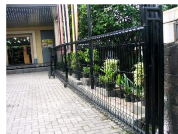
Gambar 40. Pagar pembatas yang hanya digunakan pada saat toko tutup (tidak ada aktivitas komersial). Sumber: Dokumentasi Pribadi, Juni 2004
