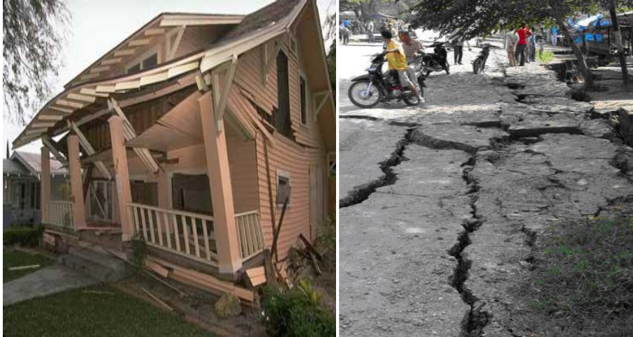
Gambar 1. 3 Kehancuran infrastruktur akibat gempa
