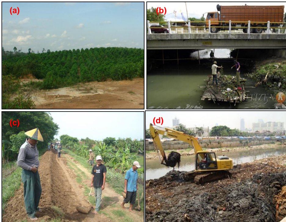
Gambar 4.5 Berbagai upaya mencegah banjir: (a) reboisasi (b) membersihkan sampah di sungai (c) pembuatan tanggul (d) pengerukan sungai
