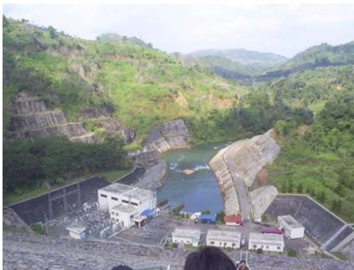
Gambar 3.23. Pembangkit Listrik Tenaga Air (PLTA) Batutege
